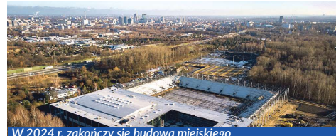
W 2024 r. zakończy się budowa miejskiego kompleksu sportowego.
